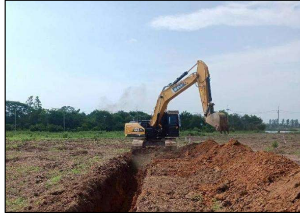
รูปที่ 1-3 งานขุดวางระบายน้ำ
