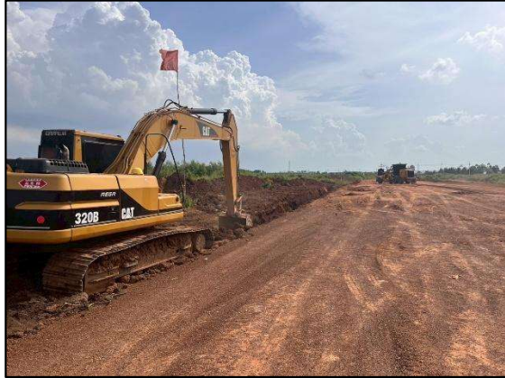
รูปที่ 1-3 งานขุดวางระบายน้ำ
